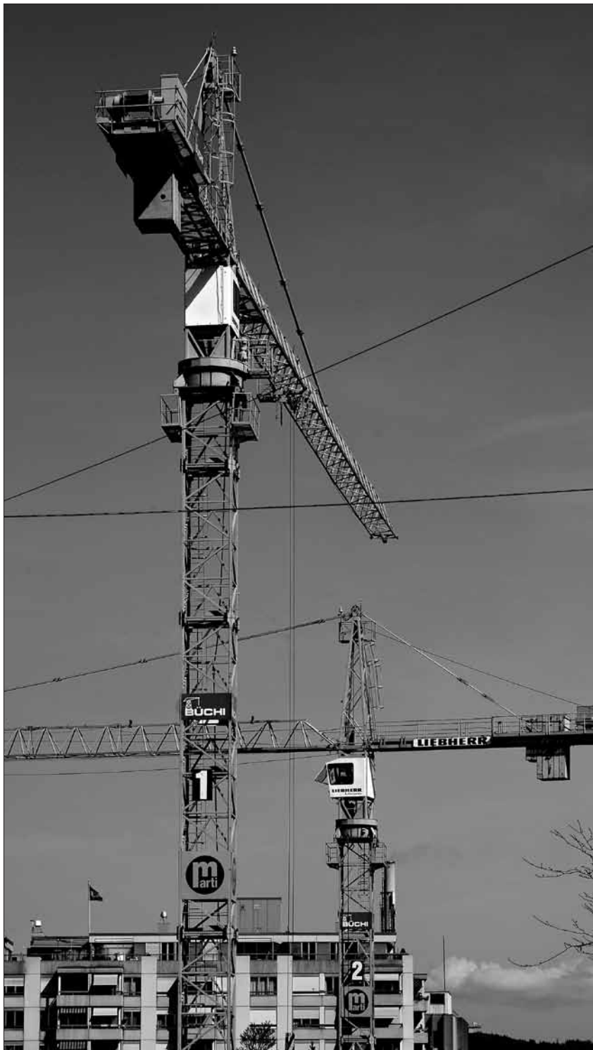
Bildthema 2.11 sind Baustellen. Ausheben, hochziehen, verputzen und später unterhalten, also überall mal flicken, bis sich der Verfall nicht mehr aufhalten lässt, eines schönen Tages dann Abbruch, planen, Ende. Fotograf Hansueli Trachsel dokumentiert diesen Prozess. Das Leben als Baustelle.
